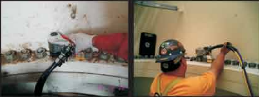
塔筒、主轴连接螺栓
