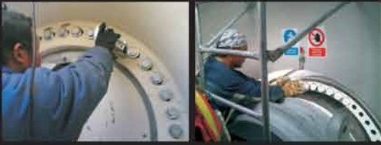
叶片连接螺栓
